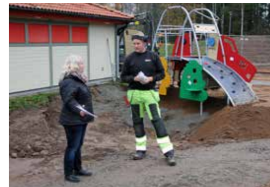
Liselott Ericsson diskuterar det slutliga färdigställandet av en av lekytorna med en av entreprenörerna.
