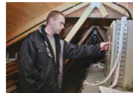
Reparatör Henrik Vernersson på vinden på Sandsbro förskola 2005.
