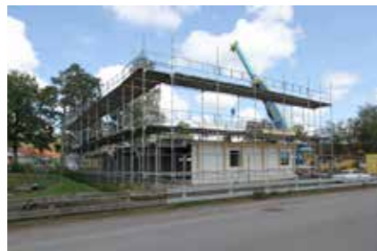
Just nu är bygget av de sex nya lägenheterna på Furulidsvägen 14 i Ingelstad i full gång.
